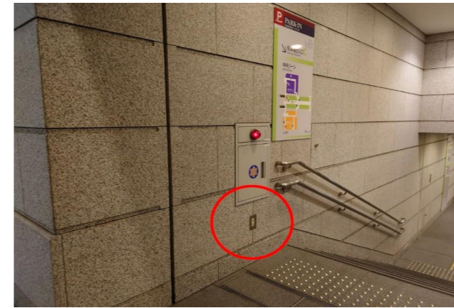
設置箇所①
