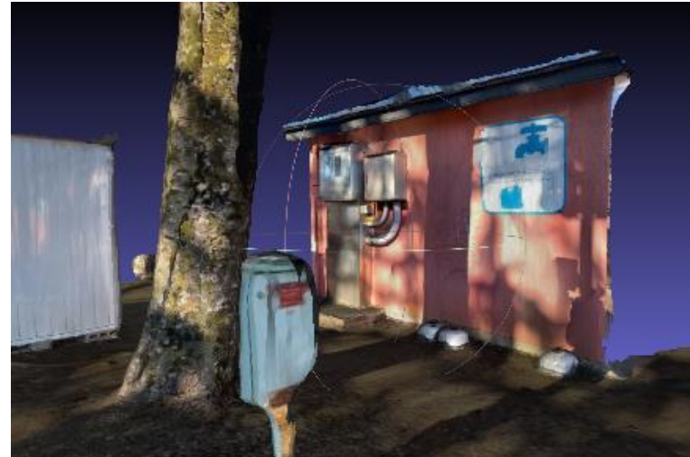
東京藝術大学学生 ホウシトウ様 災害時給水ステーション
